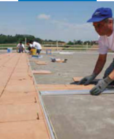
Укладка керамической плитки с применением Kerabond + Isolastic
