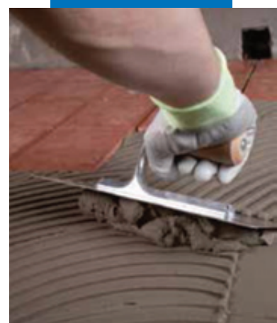
Нанесение Granirapid на гидроизоляцию Mapelastic на террасе
