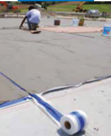
Гидроизоляция стяжки с применением Mapelastic и Mapeband
