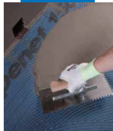
Нанесение Mapelastic на Marenet 150
