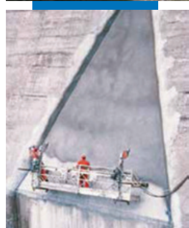
Нанесение Mapelastick на дамбу распылением
