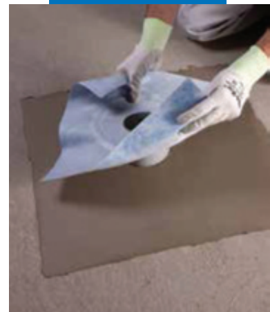
Установка вертикального дренажа на Mapelastic
